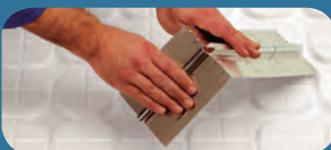
Una vez se ha completado la instalación de los paneles, se introducen a presión los difusores de calor en la ranura según el trazado de los tubos y el paso seleccionado. Los módulos difusores de calor tienen puntos de rotura controlada.
