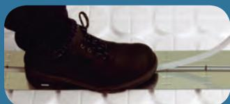
Empezando por el colector, se presiona el tubo en las chapas difusoras de calor con el pie. En la zona de desviación, el tubo es guiado en curva alrededor de las levas de desviación.
