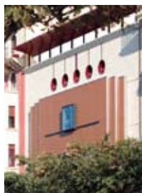
Façana del teatre Tarragona (Tarragona)
