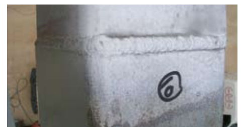
Indicació linial defectuosa causada per una falta de fusió en una soldadura inspeccionada per Partícules Magnètiques
